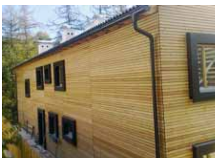
Holzhaus mit 4 Wohnungen in Aldein.
