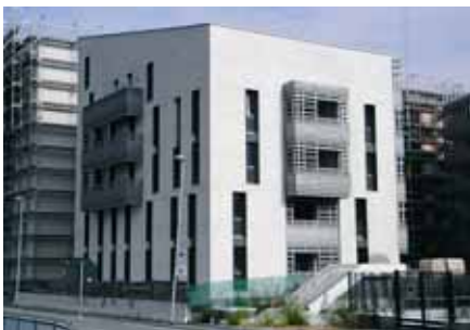
Baulos EA 8 mit 85 Wohnungen in der Kaiserau in Bozen.
