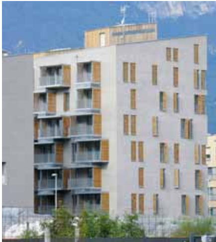
Baulos EA6 mit 81 Wohnungen in der Kaiserau in Bozen.
