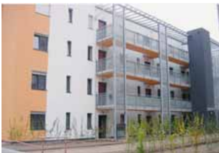
Gebäude mit 52 Wohnungen in Leifers.
