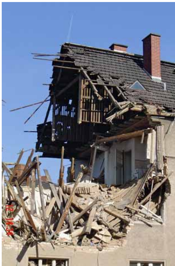
Ein Haus nach einer Gasexplosion (Foto © THW).
