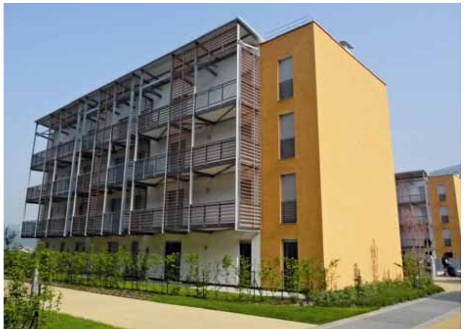
Das Gebäude in Leifers in der Josef Noldin Straße 34 - 42.
